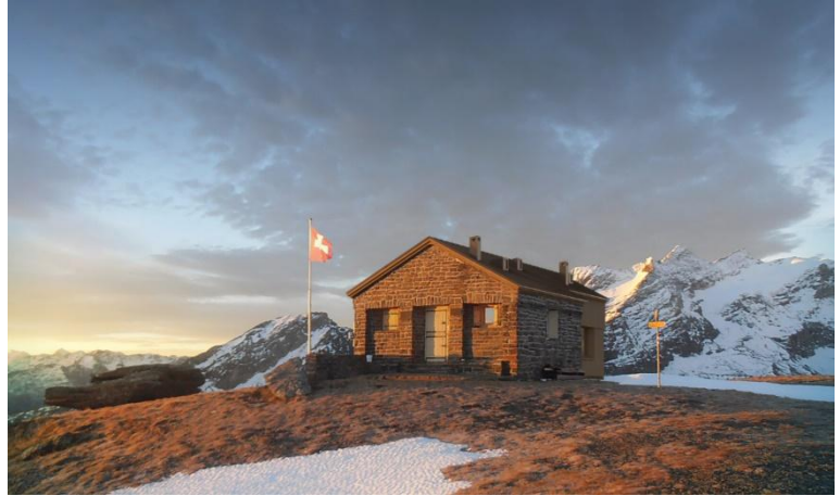
Abbildung 7: Bifertenhütte (Bild: https://www.sac-cas.ch/de/huetten-und-touren/sac-tourenportal/bifertenhuetten-2147000034/ )
